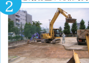
● 校庭表土の削り取り
