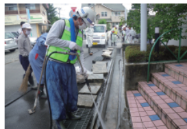
● 側溝の汚泥の除去
