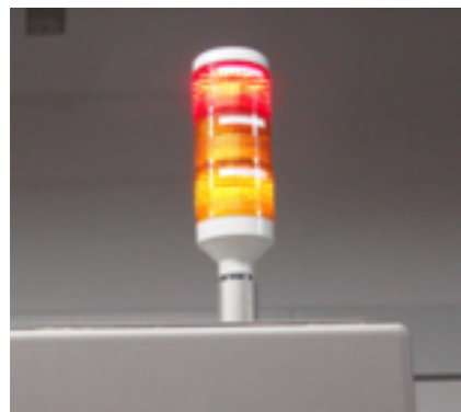
図3 外部照射ランプ
