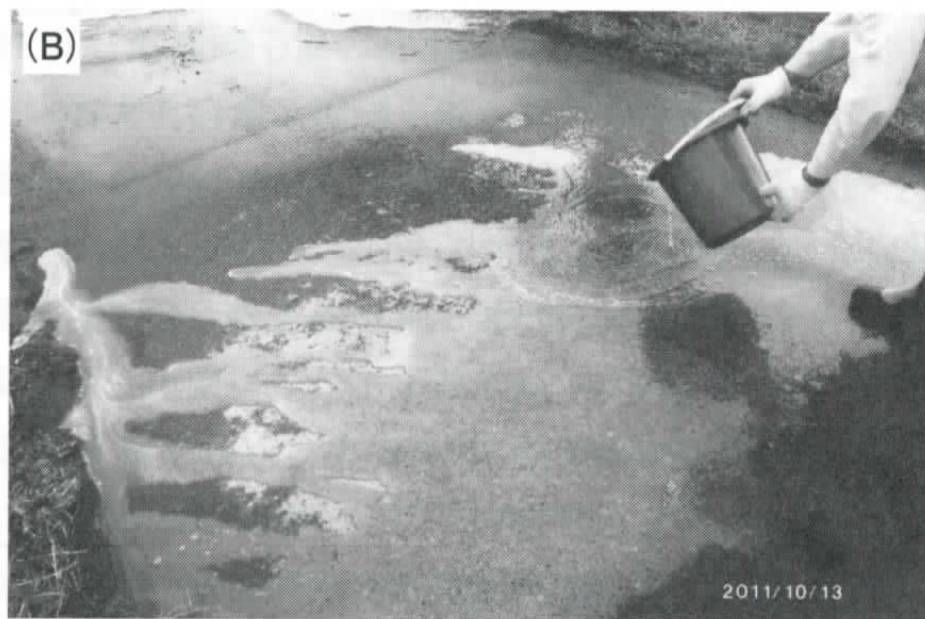
図 10 アスファルトの農道における過酸化水素による除染作業
